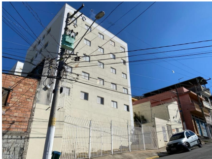
Representação Fachada Descrição Acesso principal: Av. Padre Gregório Mafra 273 Data Foto 26/08/2020
