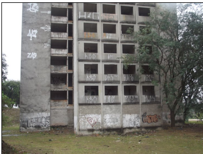
Vista da fachada oeste
