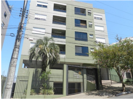
Representação Fachada Descrição Data Foto 11/12/2019
