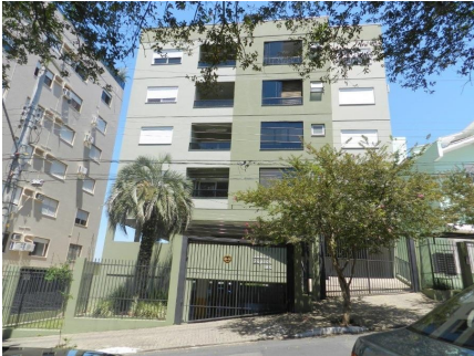
Representação Fachada Descrição Data Foto 11/12/2019
