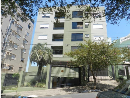
Representação Fachada Descrição Data Foto 11/12/2019
