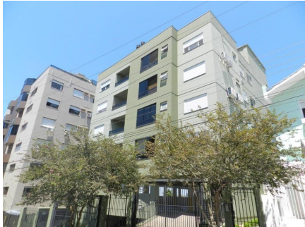
Representação Fachada Descrição Data Foto 11/12/2019
