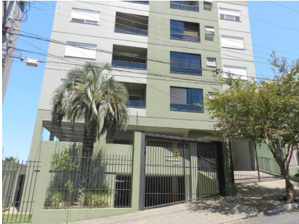
Representação Fachada Descrição Data Foto 11/12/2019
