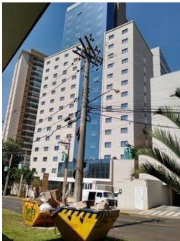
Representação Fachada Descrição Data Foto 17/02/2020
