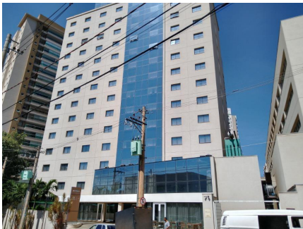
Representação Fachada Descrição Data Foto 17/02/2020
