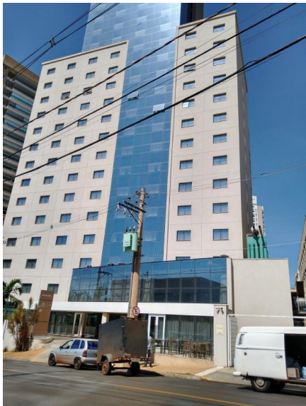
Representação Fachada Descrição Data Foto 17/02/2020
