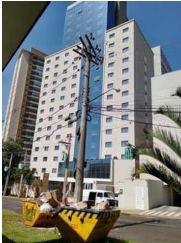
Representação Fachada Descrição Data Foto 17/02/2020
