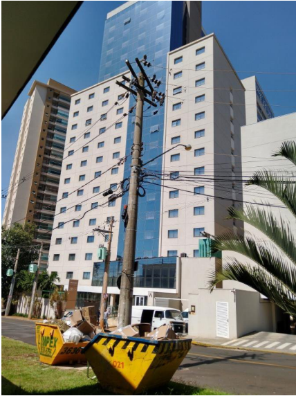
Representação Fachada Descrição Data Foto 17/02/2020
