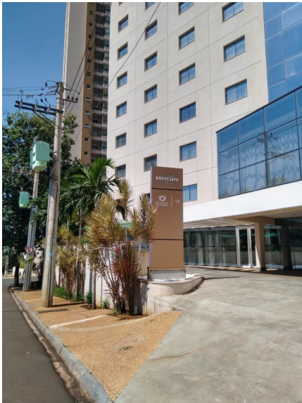
Representação Fachada Descrição Data Foto 17/02/2020
