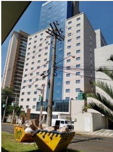
Representação Fachada Descrição Data Foto 17/02/2020
