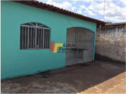
Representação Fachada Descrição Data Foto 19/12/2018
