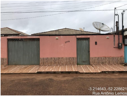
Representação Fachada Descrição Data Foto 17/12/2018
