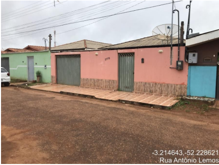
Representação Fachada Descrição Data Foto 17/12/2018
