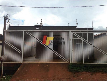
Representação Fachada Descrição Data Foto 19/12/2018
