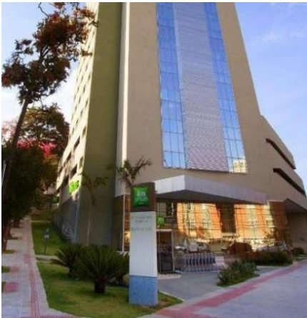
Representação Fachada Descrição Data Foto 01/07/2019
