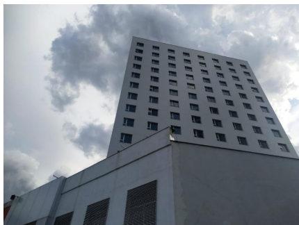
Representação Fachada Descrição Data Foto 01/07/2019
