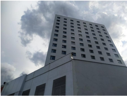
Representação Fachada Descrição Data Foto 01/07/2019
