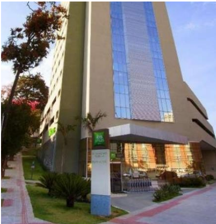
Representação Fachada Descrição Data Foto 01/07/2019
