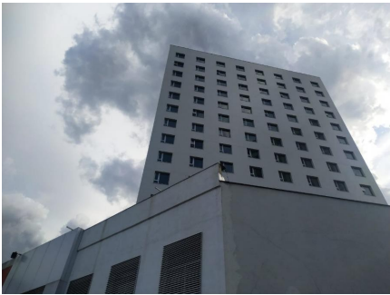
Representação Fachada Descrição Data Foto 01/07/2019
