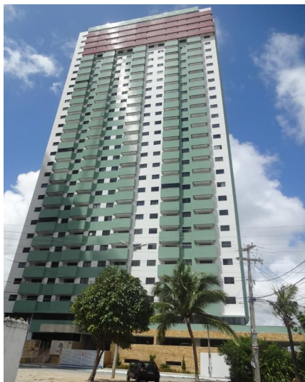
Representação Fachada Descrição Data Foto 07/02/2018
