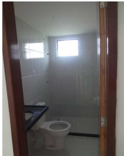
Representação Banheiro Descrição Data Foto 07/02/2018
