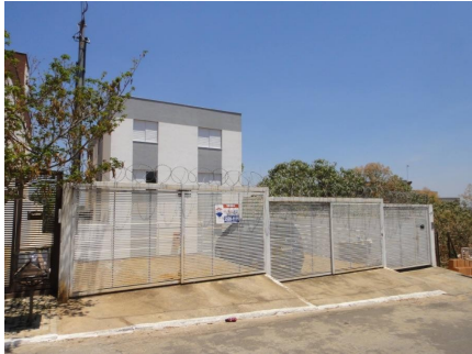
Representação Fachada Descrição Data Foto 18/10/2019
