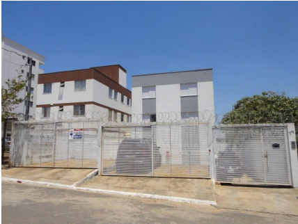
Representação Fachada Descrição Data Foto 18/10/2019
